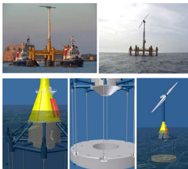
Рис. 4 Конструкция Blue H плавучего основания МПВЭС
